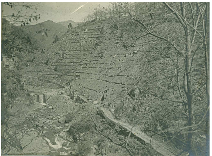
Fig.2 - Castelvittrorio (Prov. di Portomaurizio, ora IM) - Rio Gordale. Sistemazione idraulico forestale di una frana. Si osservino la briglia trasversale al rio, il muro di sponda in riparazione, le graticciate e i gradoni sui quali verranno messe a dimora le piantine
